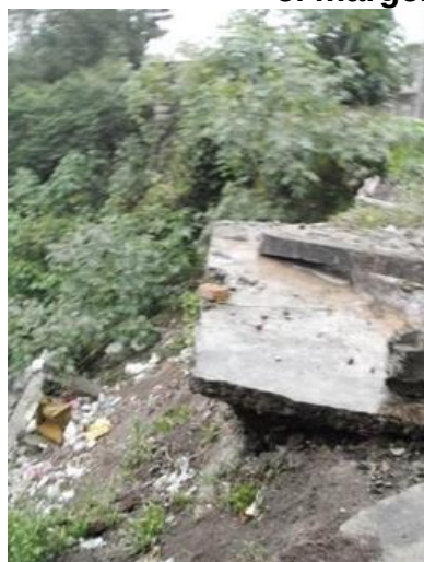
Figura 26. Puente y calle 5 de Mayo, socavación por arranque hidráulico en el margen del Río Carbonera
