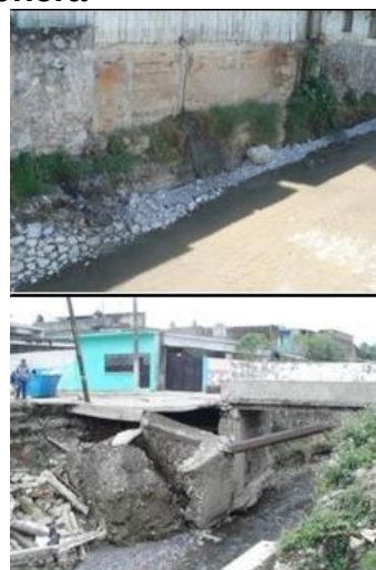
Figura 26. Puente y calle 5 de Mayo, socavación por arranque hidráulico en el margen del Río Carbonera
