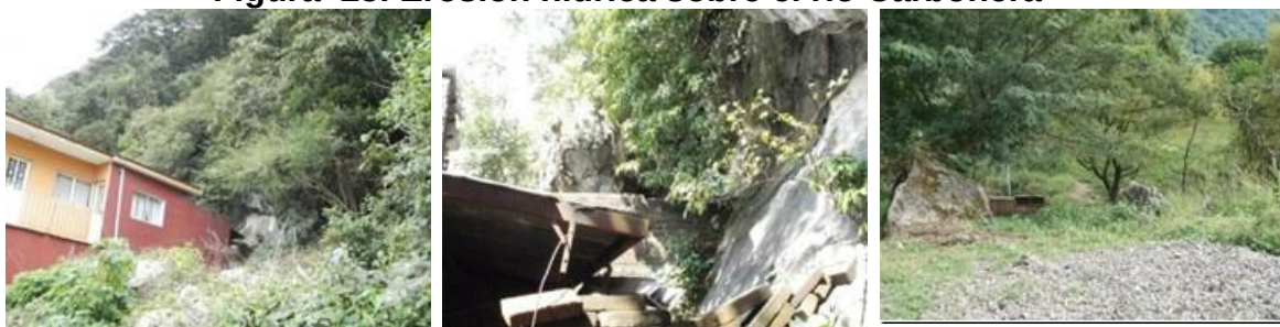
Figura 25. Erosión hídrica sobre el río Carbonera
