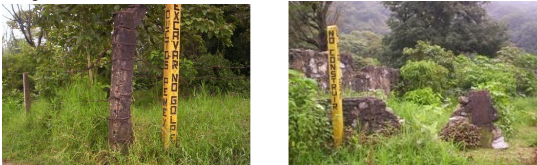
Figura 33. Ductos de PEMEX Cerro de Santa Catarina Rio Blanco
